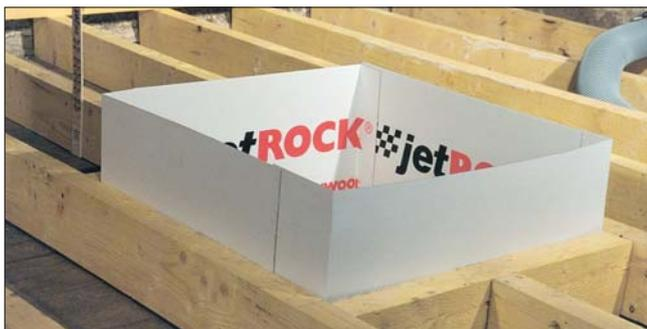
**NOTA BENE:** l'abattant de la trappe d'accès doit être isolé à l'aide d'un panneau de laine de roche fixé ou collé sur sa partie supérieure, offrant une résistance thermique au moins égale à celle de la laine soufflée.
