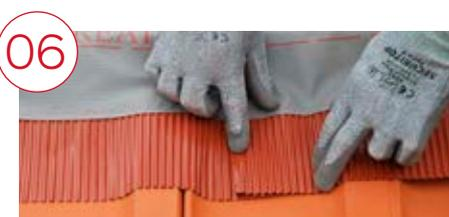
Les raccords doivent être faits en recouvrant les extrémités de 5 cm. A l'extrémité du faîtage ou de l'arêtier, couper le closoir rouleau avec des ciseaux ou un cutter. La chute peut être réutilisée lors d'un prochain chantier.
