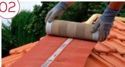
Le closoir LAHE-ROLL est déroulé et centré sur la lisse de faitage ou d'arêtier. Dans le cas de l'arêtier, dérouler le closoir LAHE-ROLL depuis l'égout et prévoir un recouvrement de 5 cm entre les rouleaux.
