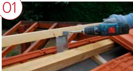
Positionner et fixer l'étrier support de lisse sur la charpente à 5 cm environ au-dessus du dernier rang de tuiles. Installer la rehausse.
