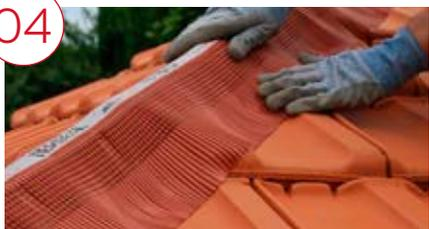
Plier le closoir LAHE-ROLL sur les tuiles en se servant des plis préformés et comprimer la bavette uniformément dans le courant des tuiles des 2 côtés de la rehausse. Veiller à ne pas trop presser la partie centrale perforée sur la rehausse afin de ne pas diminuer la capacité de ventilation.
