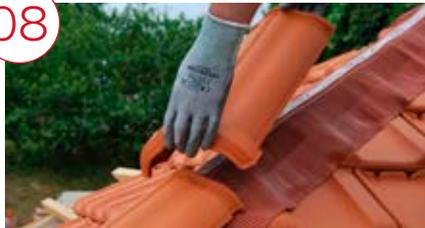
Recouvrir le closoir LAHE-ROLL avec les tuiles faîtières ou les arêtiers. La partie perforée ne doit pas dépasser de la faîtière. Conformément aux DTU de la série 40, le recouvrement des faîtières se fait dans le sens opposé à celui des vents dominants. La fixation des faîtières se fait soit par vis soit à l'aide de clips de faîtière adaptés.
