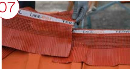
Les raccords doivent être faits en recouvrant les extrémités de 5 cm.
