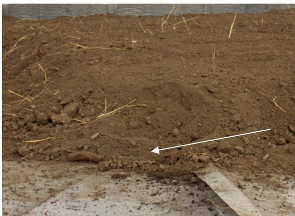
Approvisionner la terre directement sur la nappe Enkadrain® en privilégiant une mise en œuvre dans le sens des recouvrements pour bénéficier de l'effet « tuile ». Maintenir impérativement une couche de terre d'au moins 30 cm sous l'engin.
